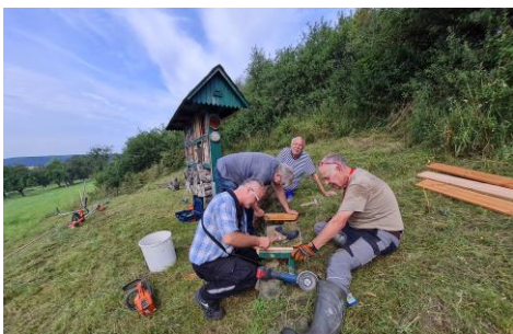
Zu viert wurde die alte Bank demontiert
